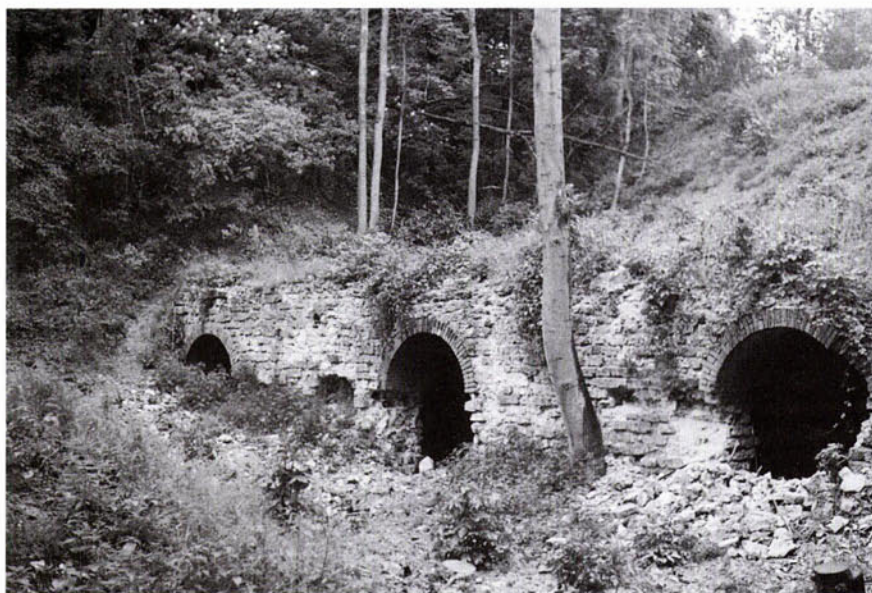
De kalkoven in Schin op Geul voor de herstelwerkzaamheden.
